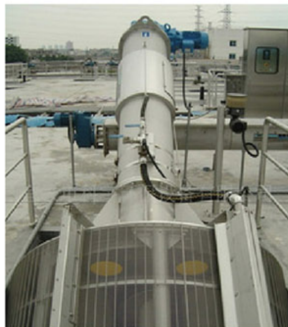
图3 转鼓式格栅除污机
