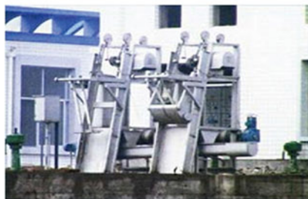
图1 钢丝牵引平面格栅除污机
