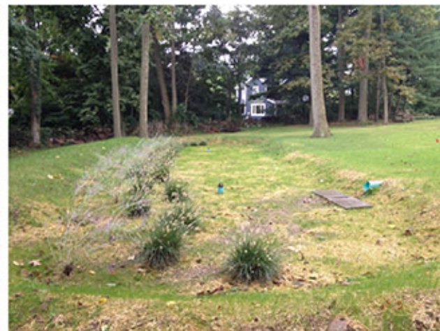
住宅不透水区域的生物滞留系统
