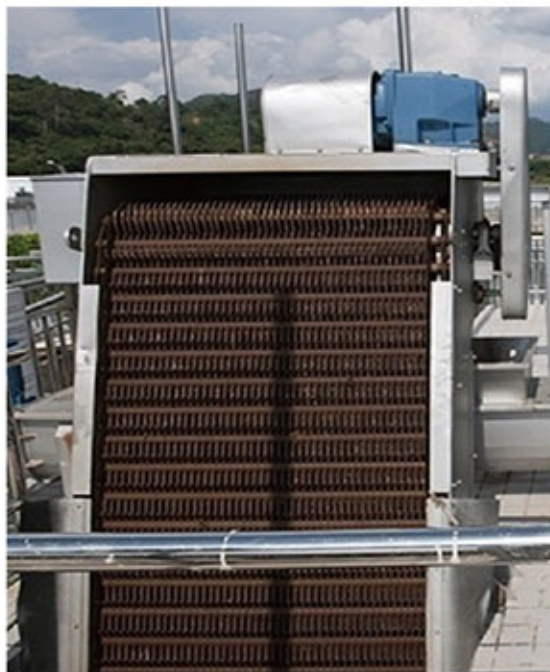
图2 旋转式格栅除污机
