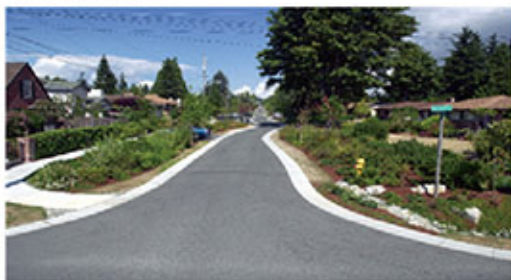
改造后的低影响开发道路(生态滞留池和植草沟将径流量减少到降雨量的10%，并保证两年一遇降雨产生的径流量为小区开发前的自然森林状态)
