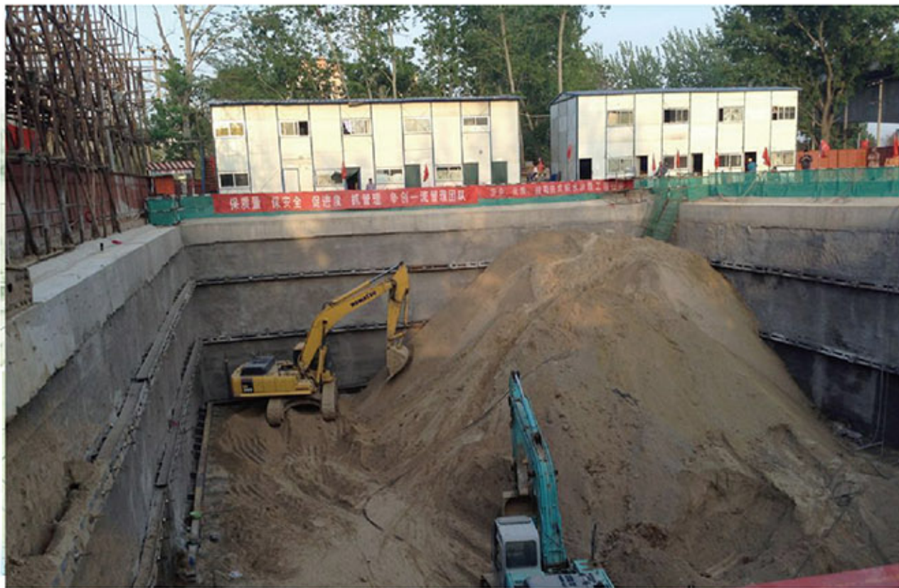
正在建设中的北京蓄水池
